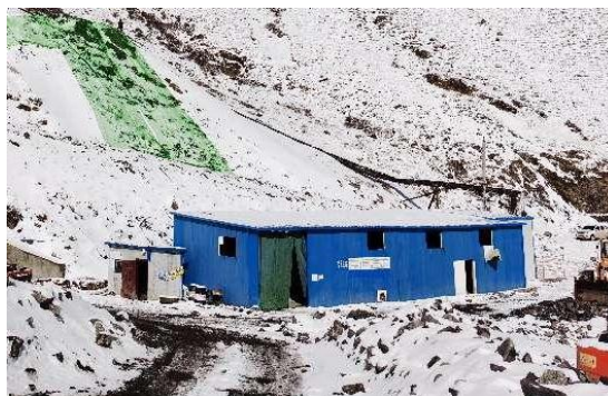
照片 2-4 机修车间
