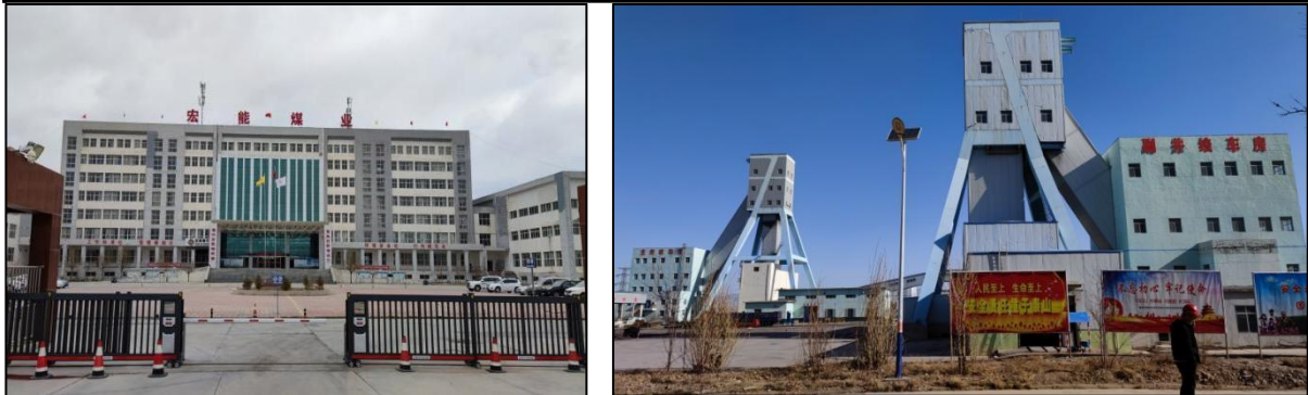
照片 3.3-1 现工业场地
