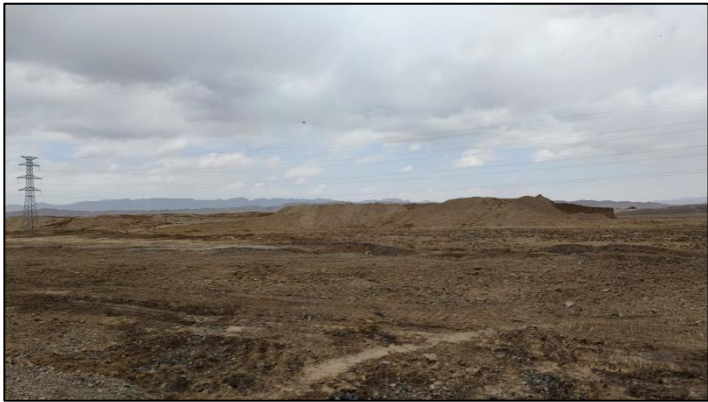
照片 3.4-5 表土堆场
