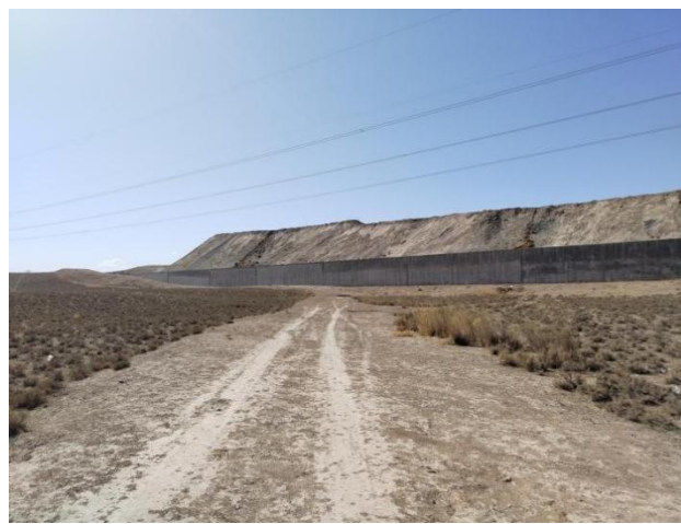
图 1.5-4 排矸场侧面照片
