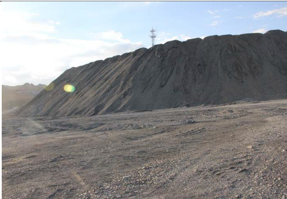
图 4-2 X1 不稳定斜坡现状图
