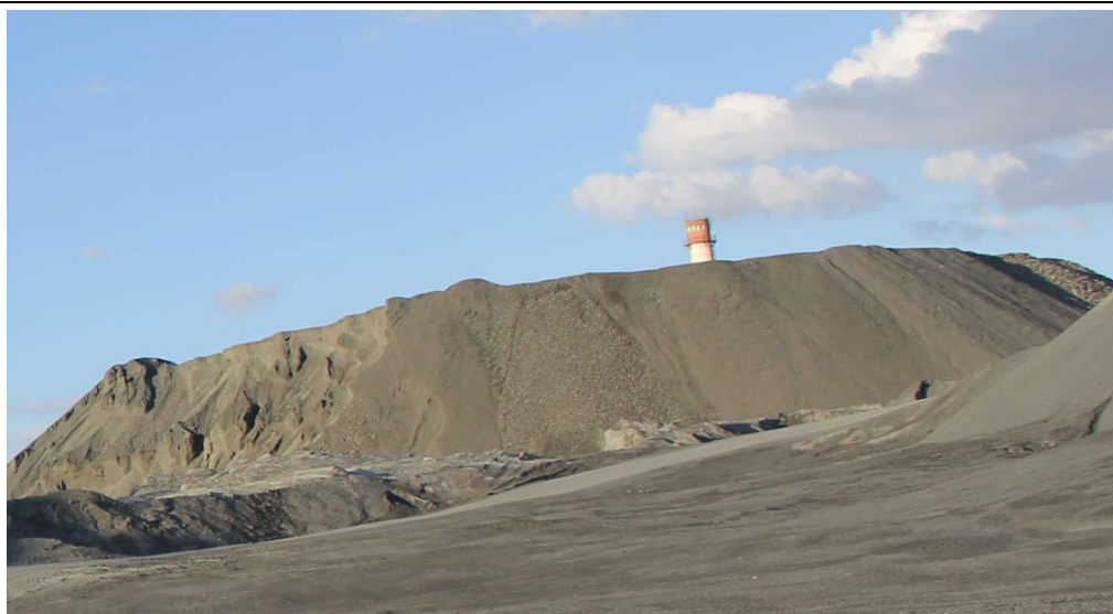
图 4-4 X2 不稳定斜坡现状图
