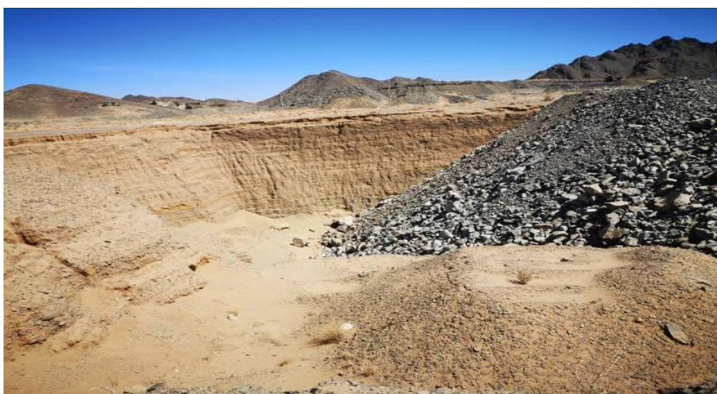
图 2-14 原有露天采坑部分回填实拍图
