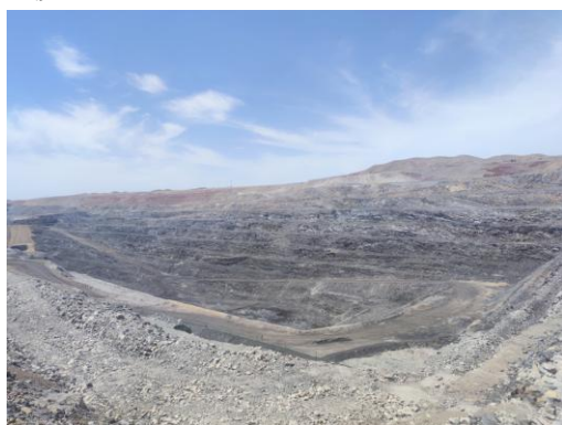
照片 3-2-1 X1 不稳定斜坡
