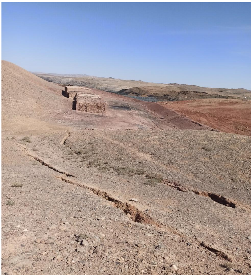
图 1-1-5 原君泰采矿权西端地表裂缝
