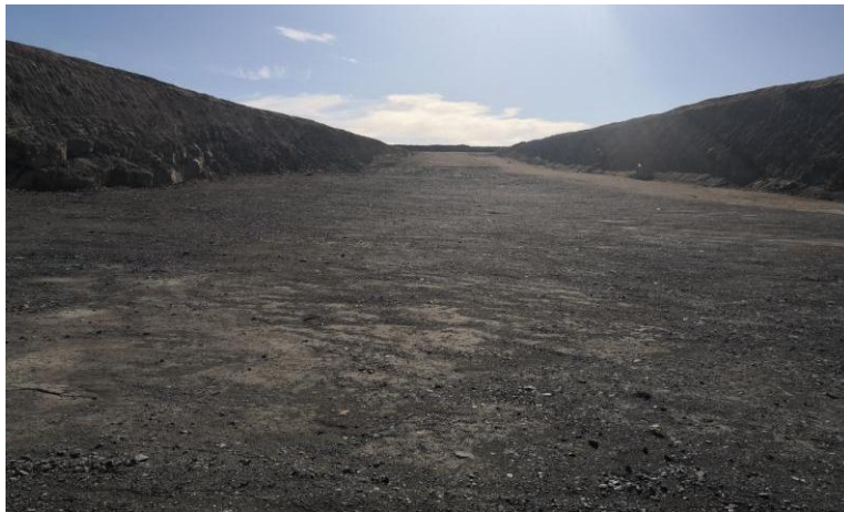
照片 2-6-1 X1 不稳定斜坡削坡治理
