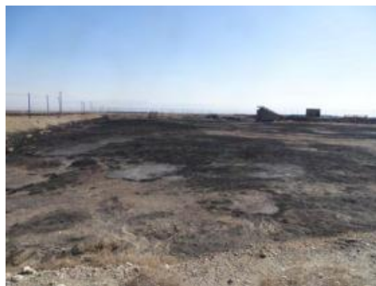
照片 2-6-12 储煤场周边拦水坝
