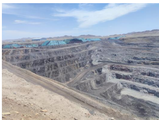
照片 3-2-2 X2 不稳定斜坡
