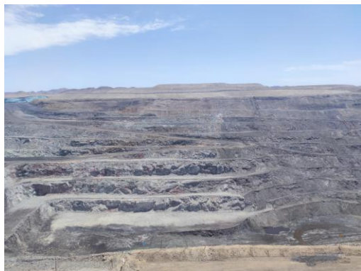
照片 3-2-3 X3 不稳定斜坡
