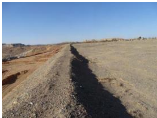
照片 2-6-11 采场周边拦水坝
