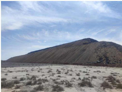
照片 3-2-5 X5 不稳定斜坡
