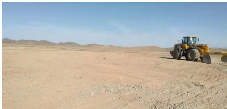
照片 2-1 东采区排土场顶部
