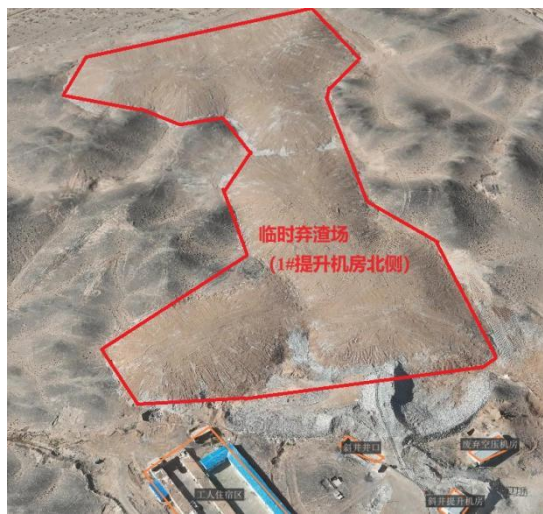
图 2-15 1#提升机房北侧临时弃渣场
