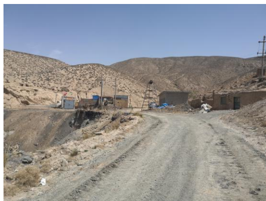
照片 1-3-6 风井工业场地
