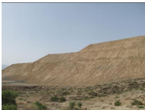
照片 2-6-3 碎石山治理
