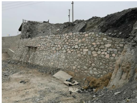
照片 2-6-6 不稳定斜坡治理
