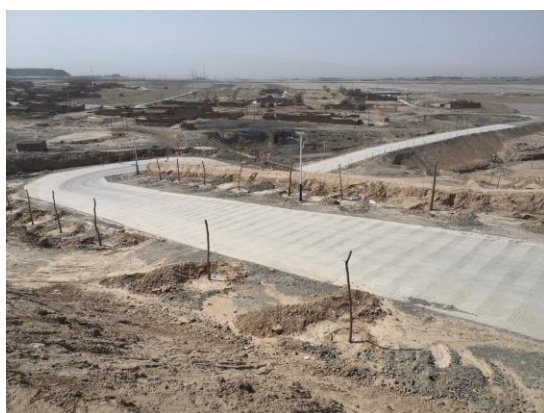
照片 1-3-6 主副井工业场地道路
