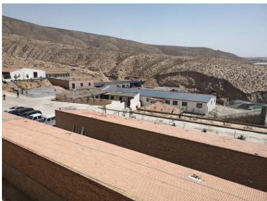
照片 1-3-3 副井工业场地
