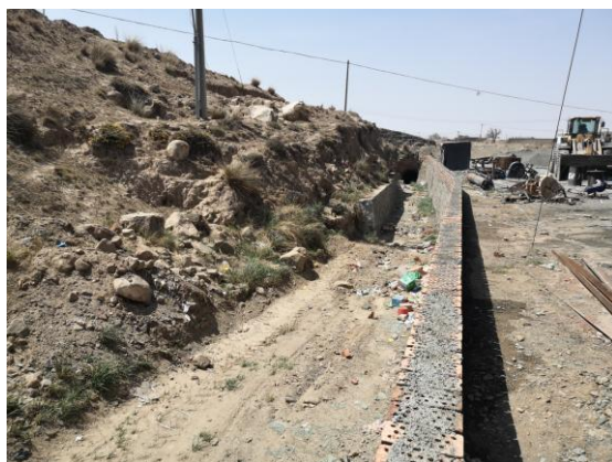
照片 2-6-2 清理、加固排洪沟道
