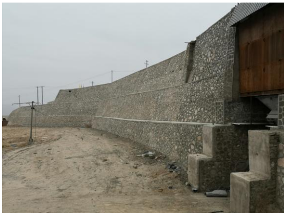
照片 2-6-5 不稳定斜坡治理
