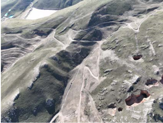
照片 1-11 已建矿山道路
