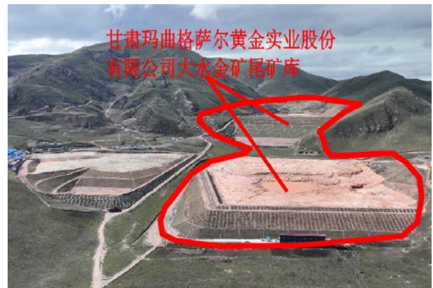
照片 1-2 甘肃玛曲格萨尔黄金实业股份有限公司大水金矿已建尾矿库
