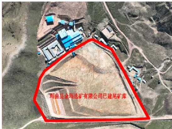
照片 1-3 玛曲县金玛选矿有限公司已建尾矿库
