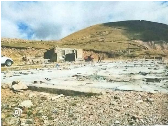
照片 2-6 建筑物拆除
