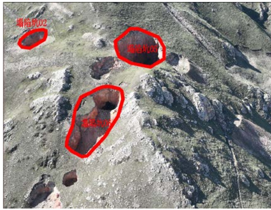
照片 1-1 已有塌陷坑
