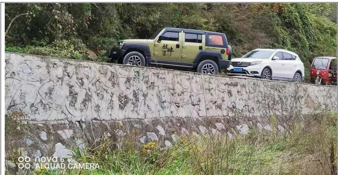
照片 2-7 X02 不稳定斜坡挡墙工程
