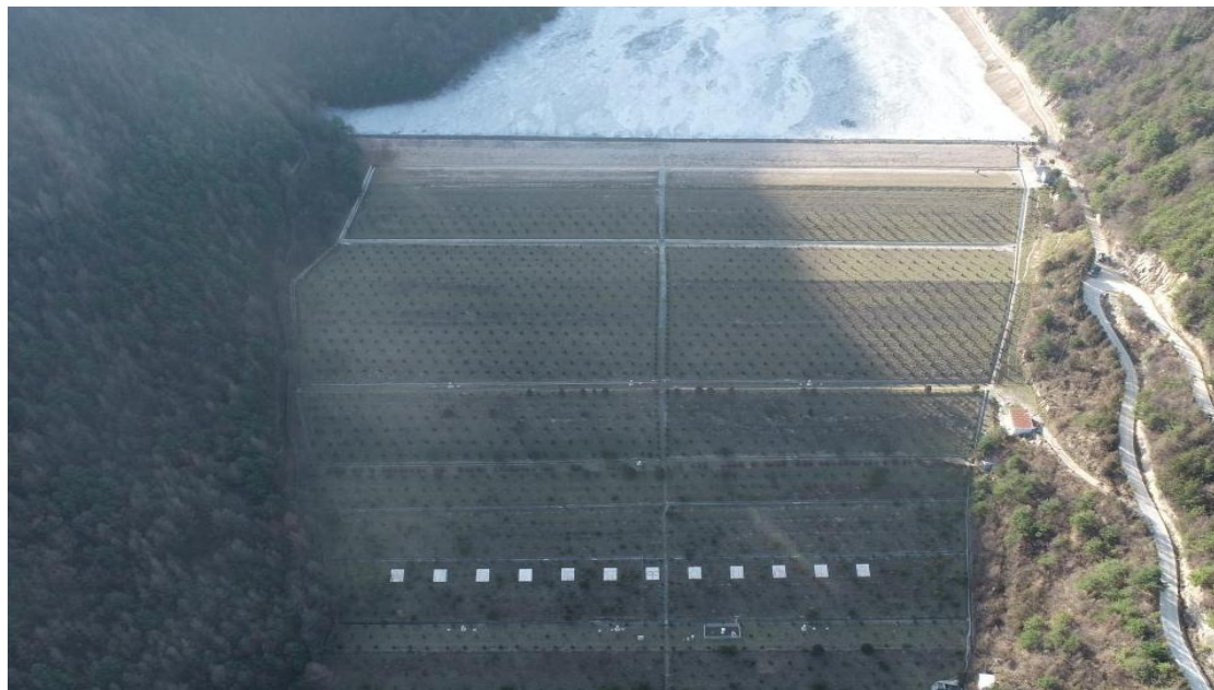
照片 3-6 尾矿库现状
