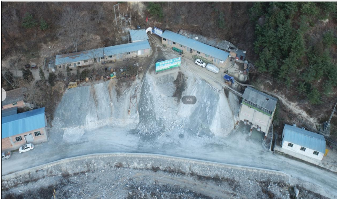
照片 3-4 2#堆矿区现状
