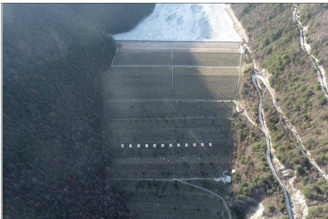
照片 1-4 尾矿库场地航拍图
