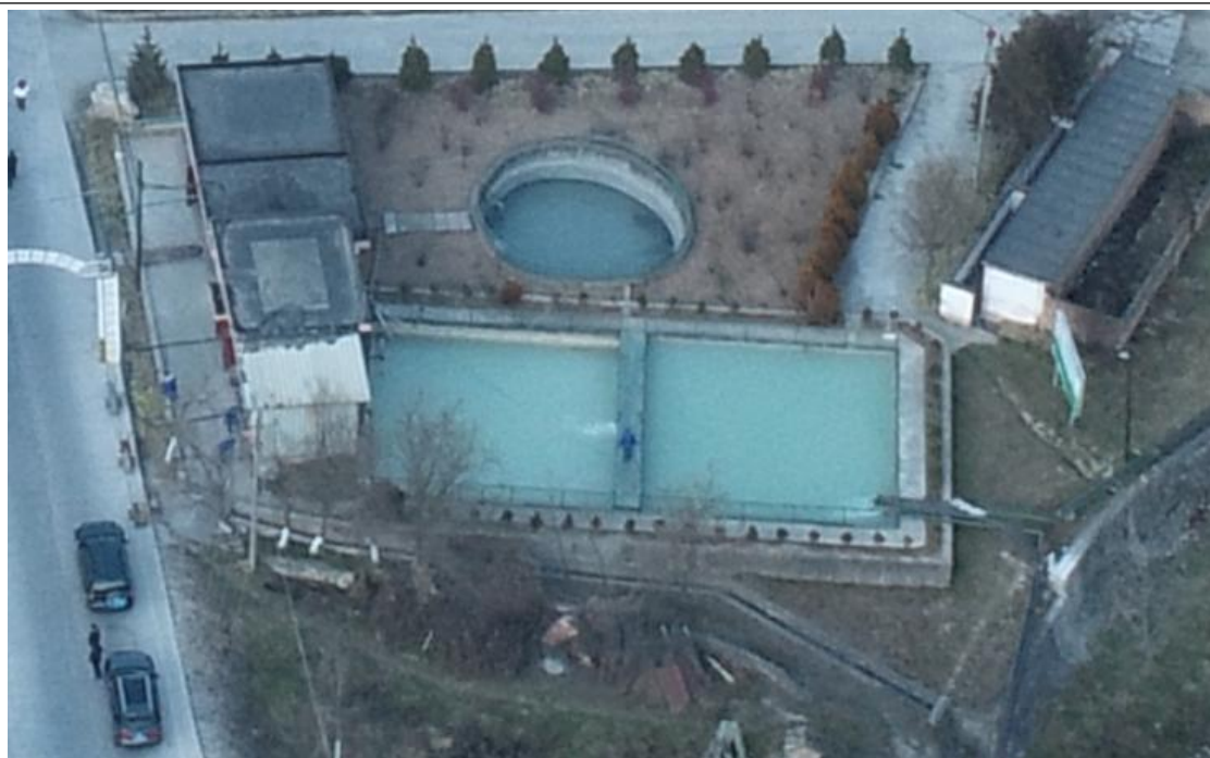
照片 3-7 沉淀池及加压泵房现状
