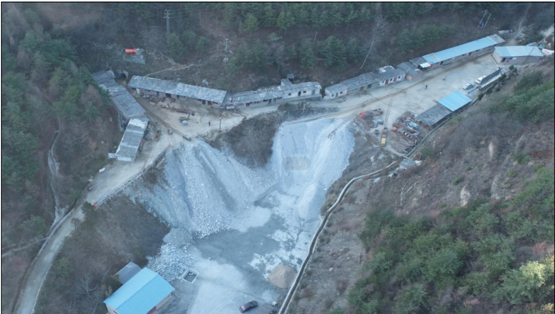
照片 3-3 1#堆矿区现状
