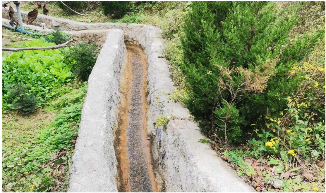
照片 2-6 X01 排水渠工程
