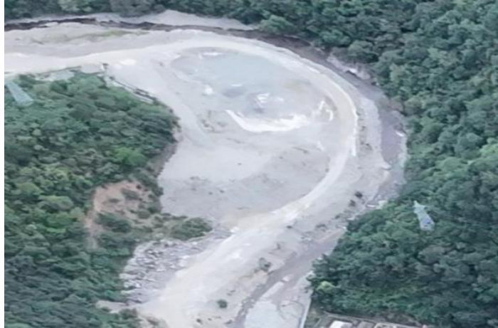
照片 3-4 堆渣场 1 (X02 不稳定斜坡) 现状图
