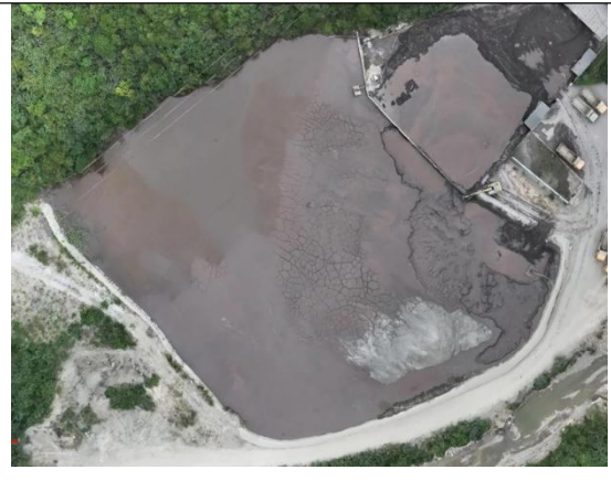
照片 1-14 沉淀池现状
