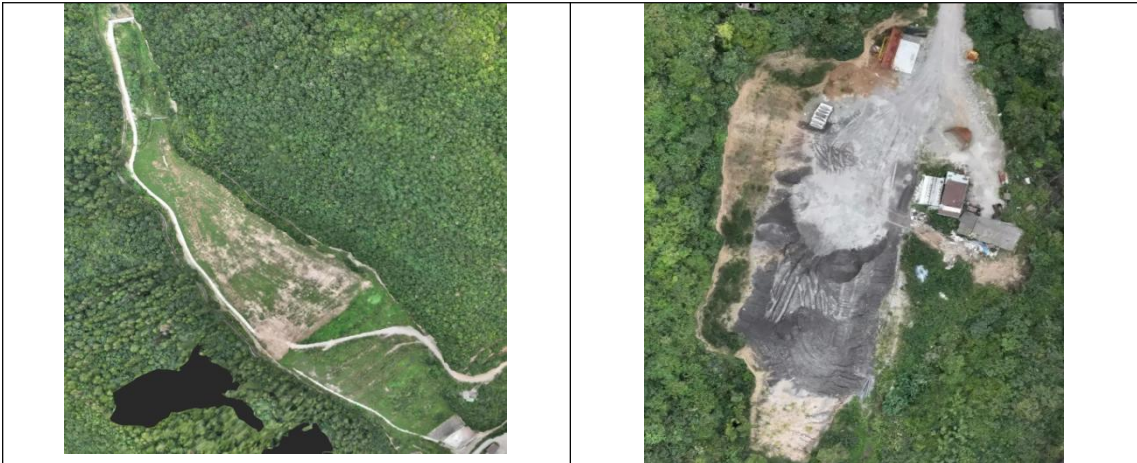
照片 1-11 尾矿库现状
