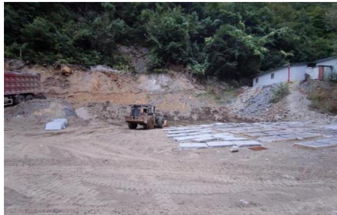
照片 3-3 堆渣场 1 现状图
