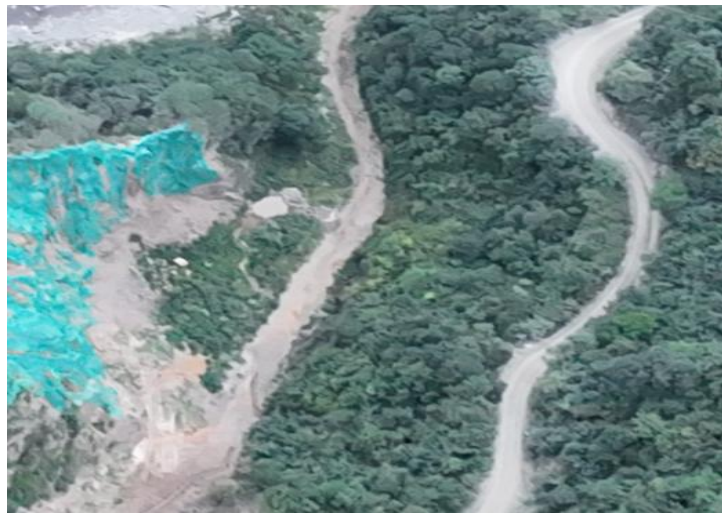
照片 3-10 采矿评估区矿区道路现状图
