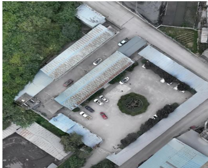
照片 3-12 选矿区办公生活区现状图
