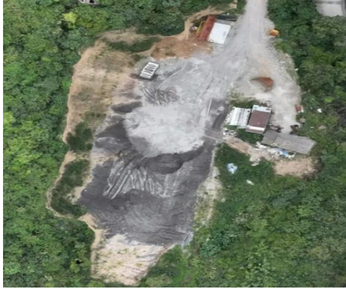
照片 3-15 选区临时弃渣场现状图
