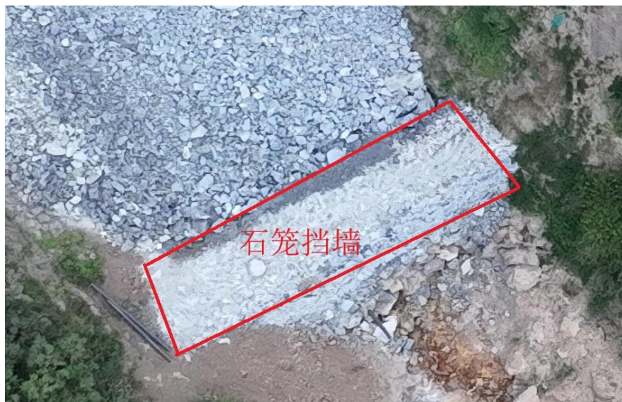
照片 2-15 临时弃渣场底部石笼挡墙现状
