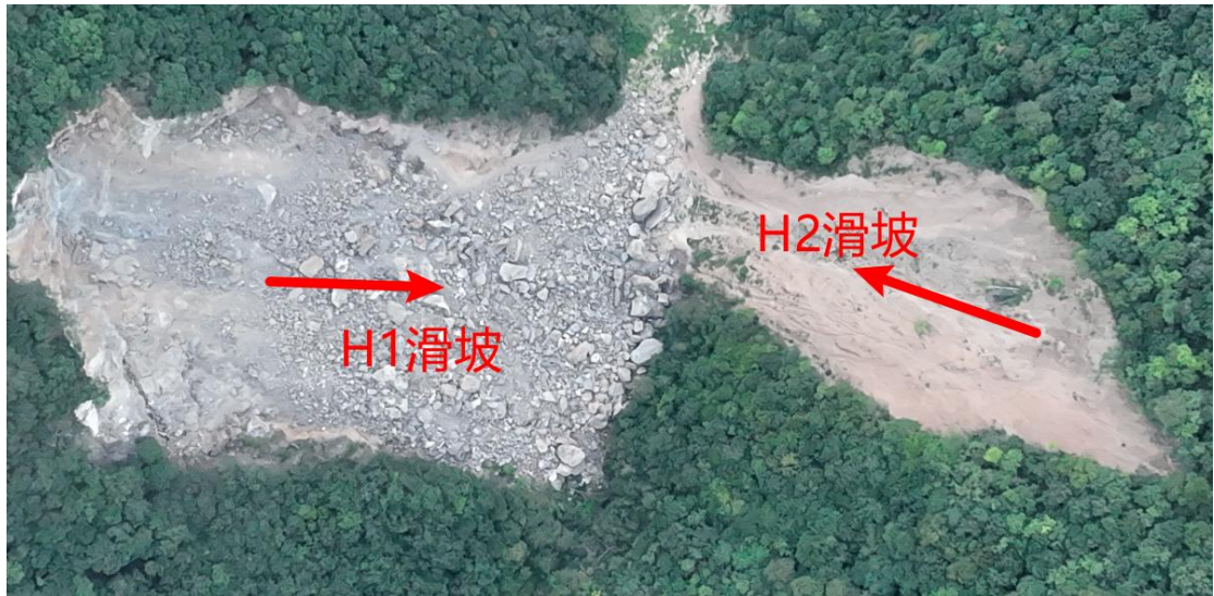
照片 3-11 H1、H2 滑坡现状图
