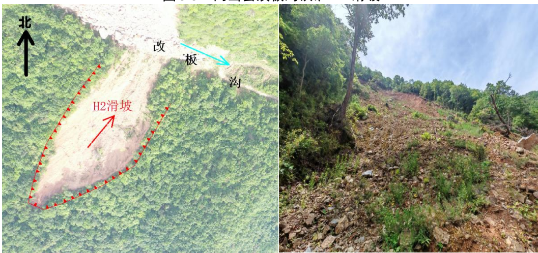
(a) H2 滑坡全景图 (b) H2 滑坡底部 图 3-4 两当县改板沟铁矿 H2 滑坡
