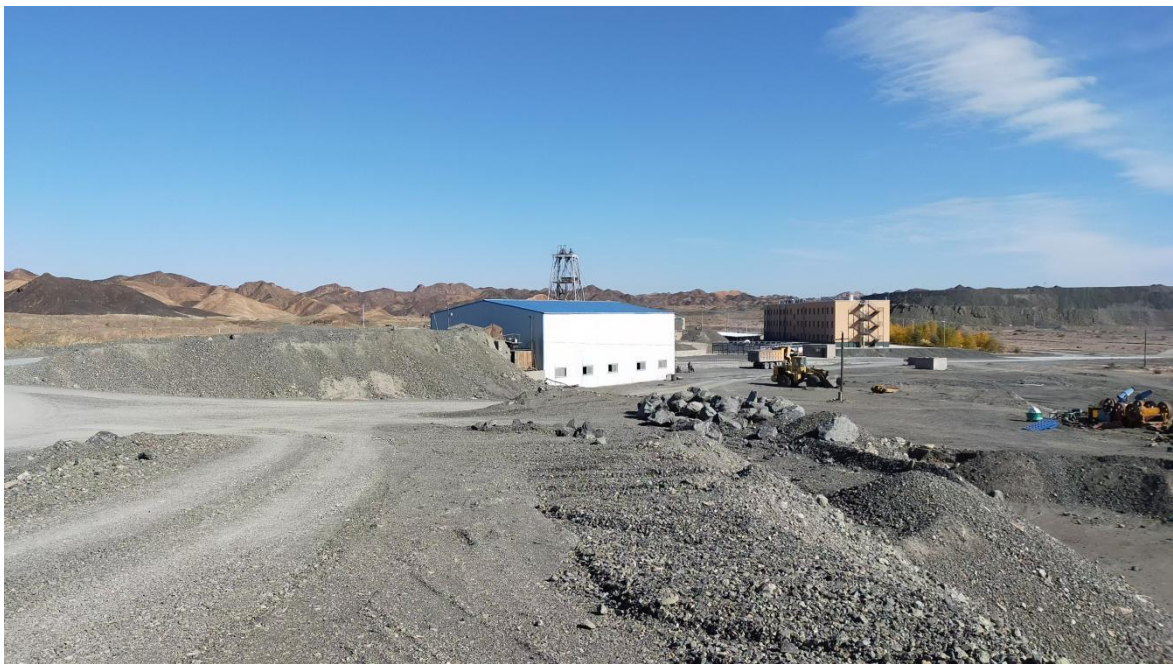
照片 2-5-1 矿区工程建设
