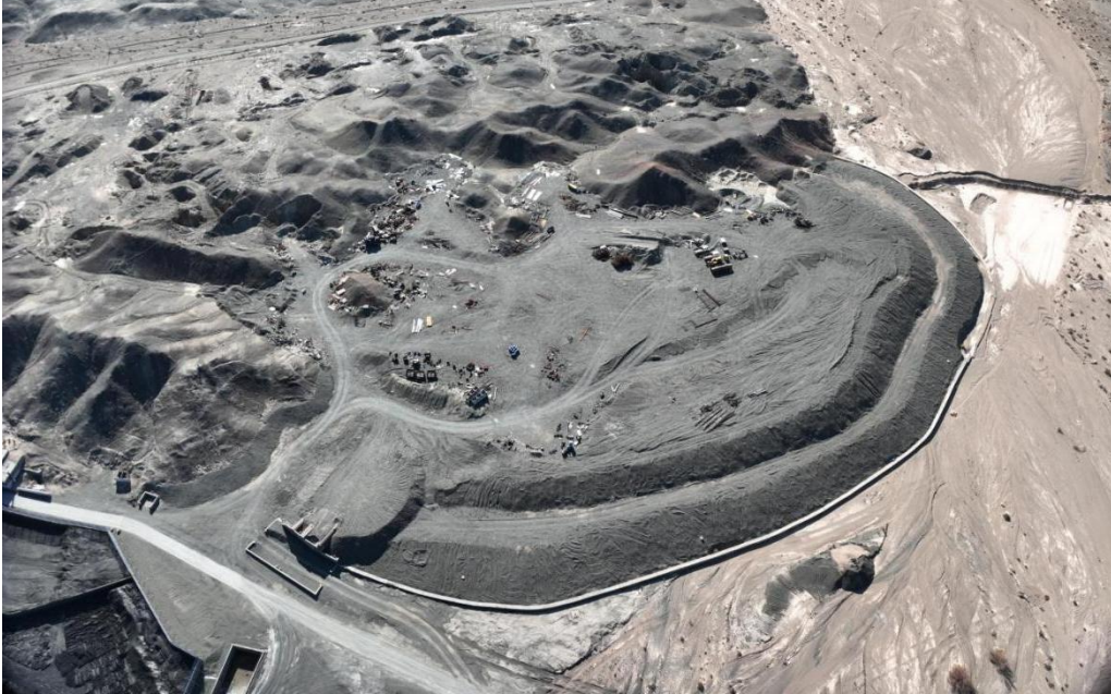
照片 2-6-1 闭库尾矿库治理情况
