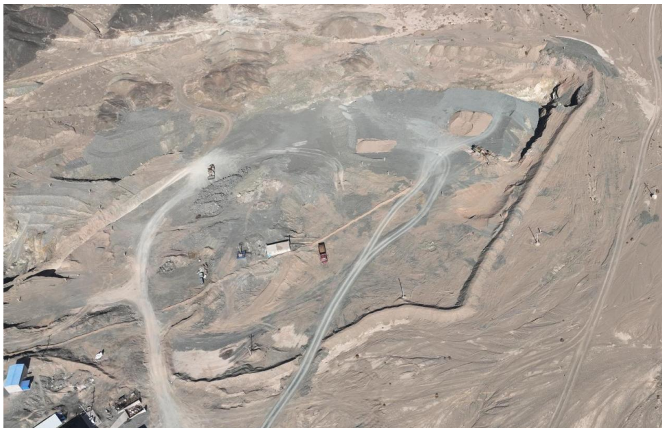
照片 2-6-2 2#、3#采坑回填治理情况
