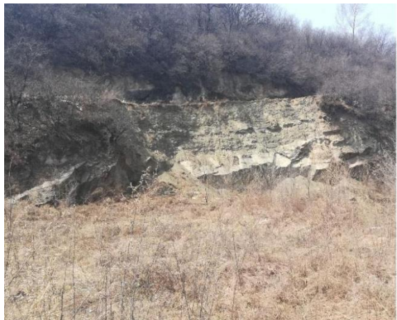
照片3.2-3 B3崩塌
