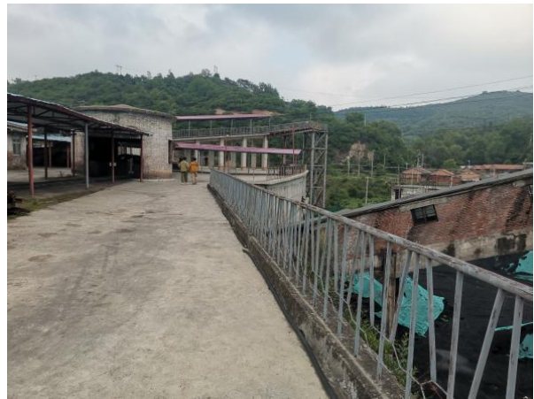
照片 2.6-2 已治理挡墙
