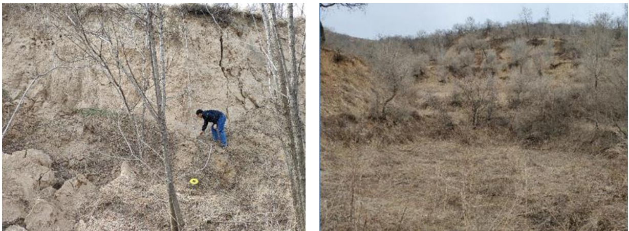
照片 3.2-7 塌陷范围内裂缝（T3）
