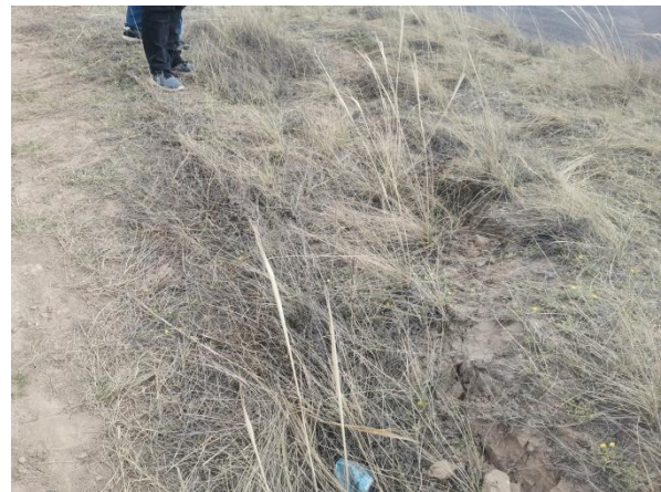
图 2.6-2 裂缝充填后现场照片
