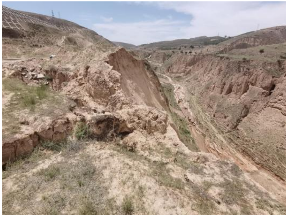
图 3.2-8 X4 不稳定斜坡现场照片
