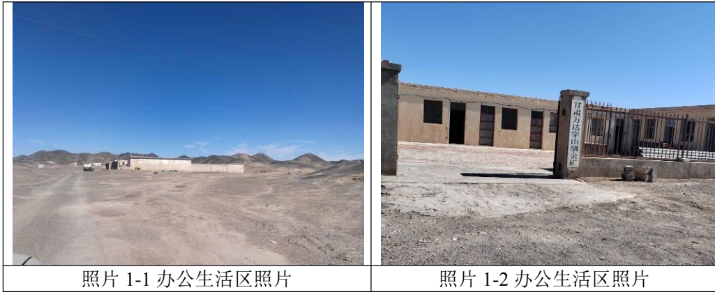
照片 1-1 办公生活区照片
