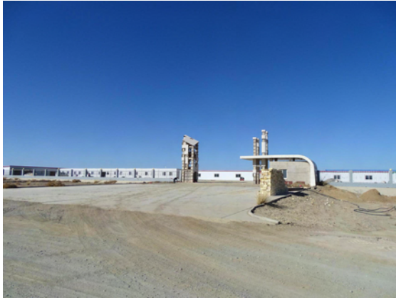
照片 1-4-1 现状工业场地
