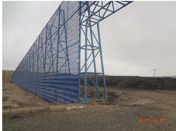
照片 1-5-2 红沙梁矿储煤场
