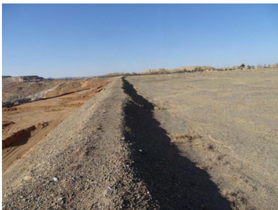
照片 2-6-1 采坑周边拦水坝
