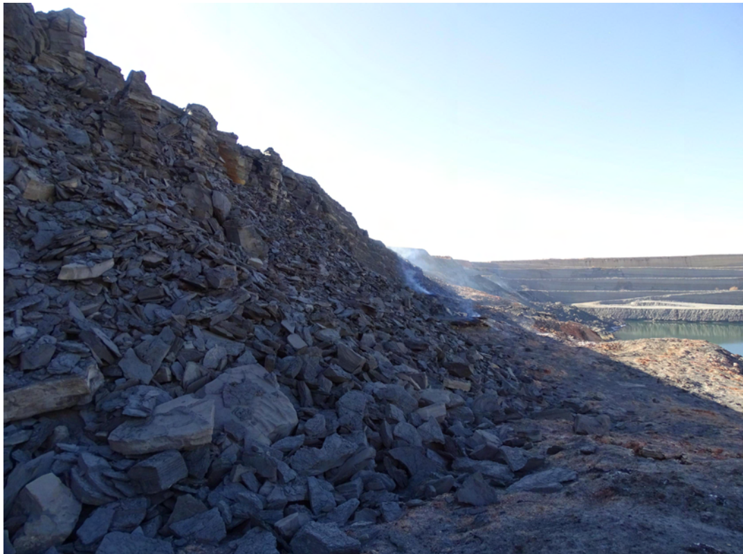
照片 3-2-1 煤层自燃引发滑坡
