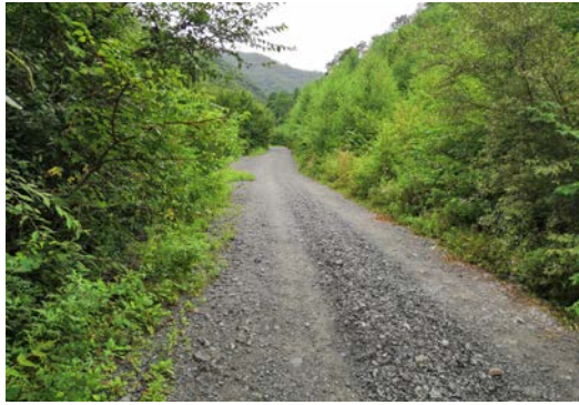
照片 1-9 矿山道路（沈家沟）
