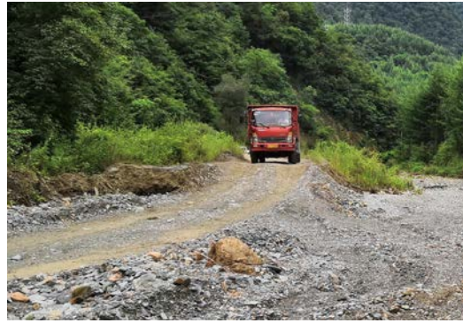
照片 1-10 矿山道路（宽沟）
