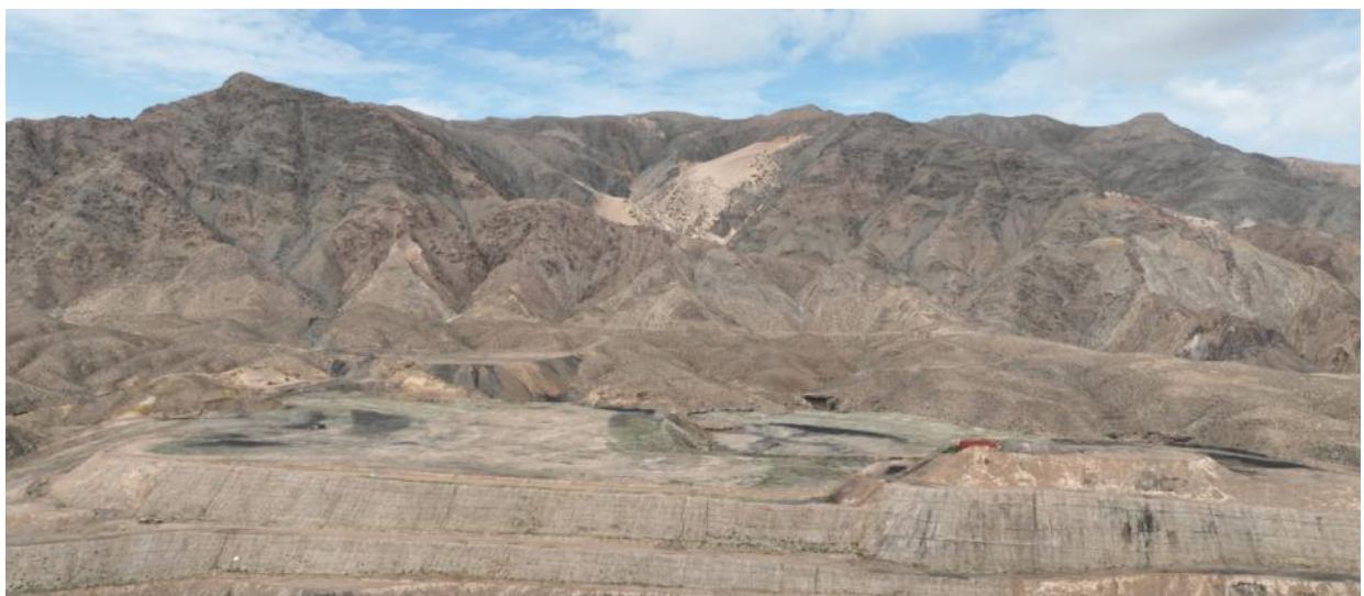
图 1.5-4 治理完成后现状
