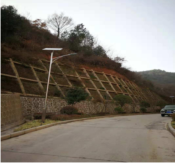
图 3-12 厂区格构梁挡墙
