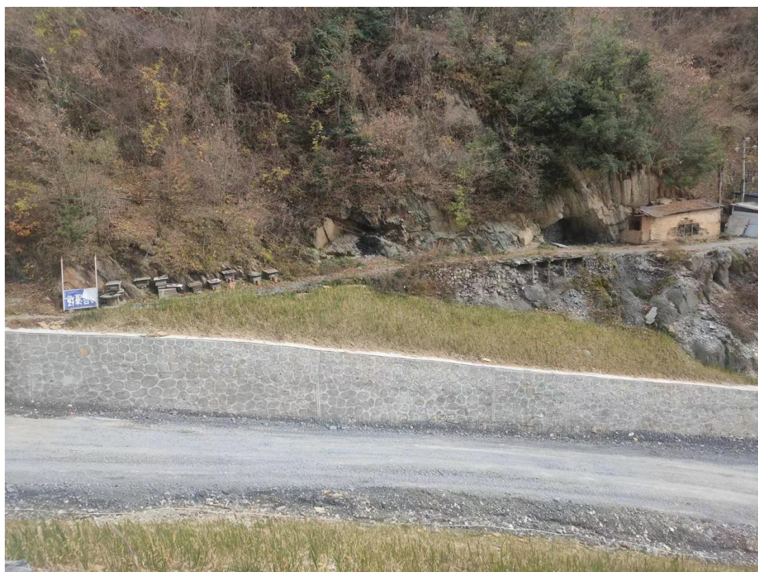
图 3-17 挡墙及护坡绿化表
