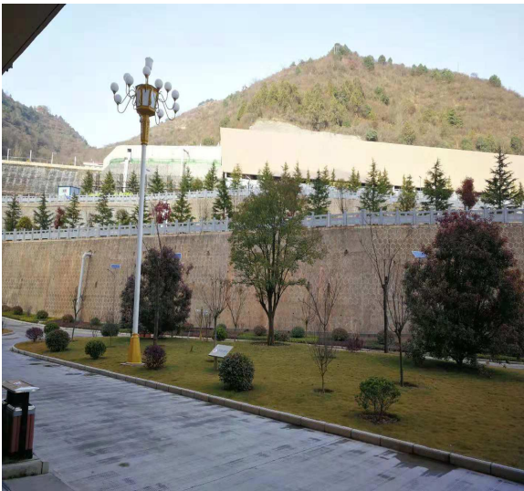
图 3-14 厂区钢筋混凝土挡墙
