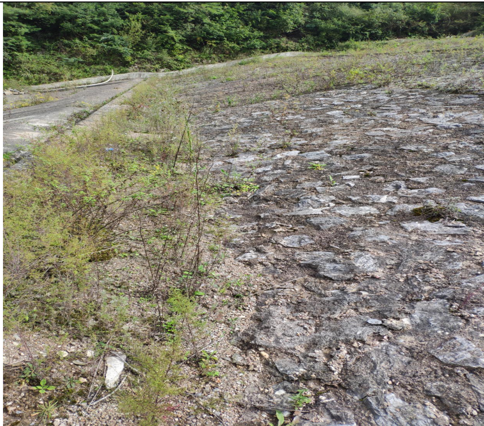
图 3-16 复垦后的大沟尾矿库
