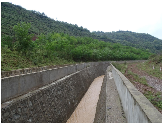
照片 2-10 坡脚排洪渠
